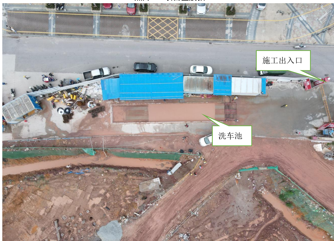
照片 2 项目施工出入口
